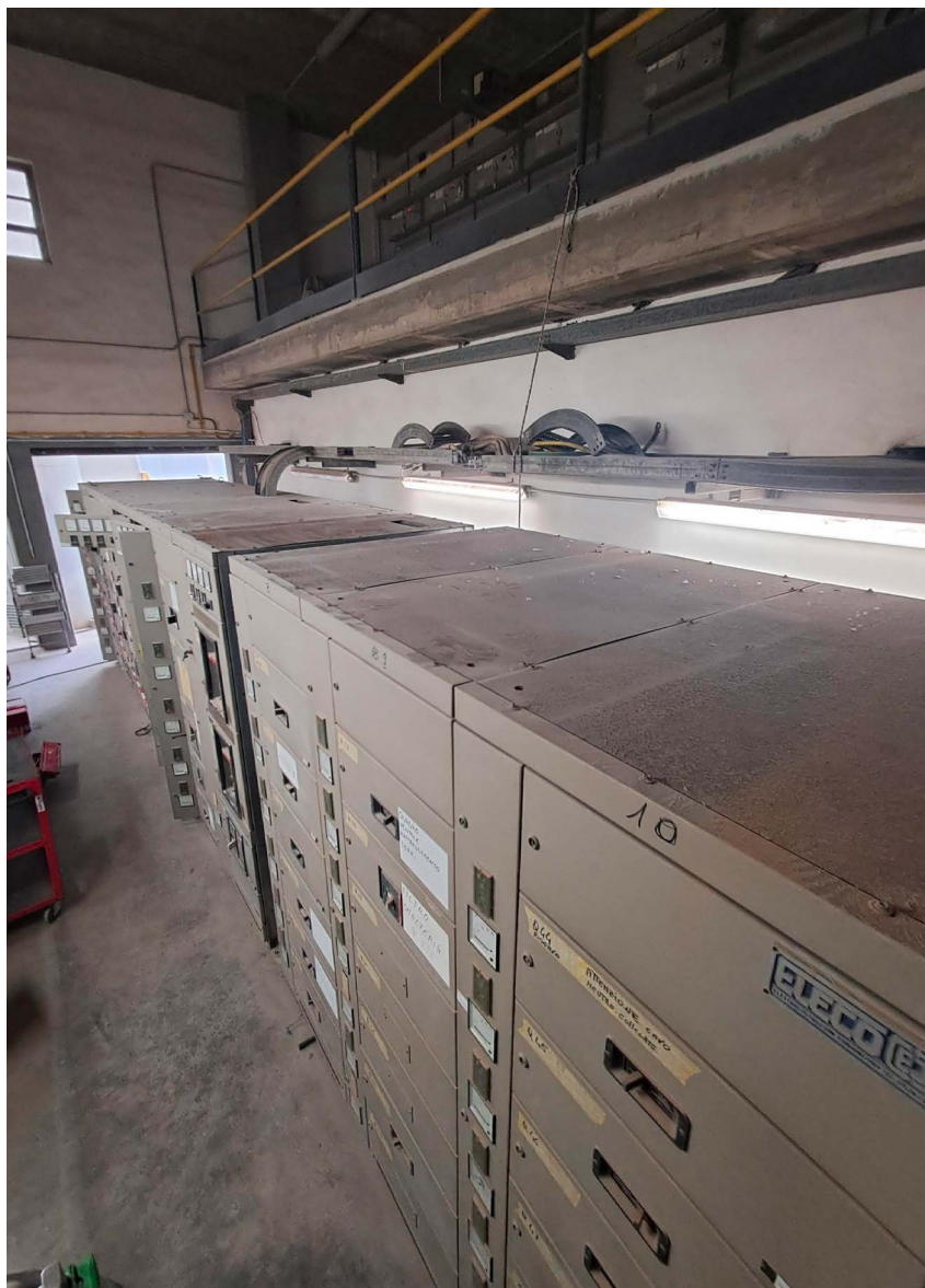
↑ Vista superiore quadro elettrico esistente oggetto di revamping.
