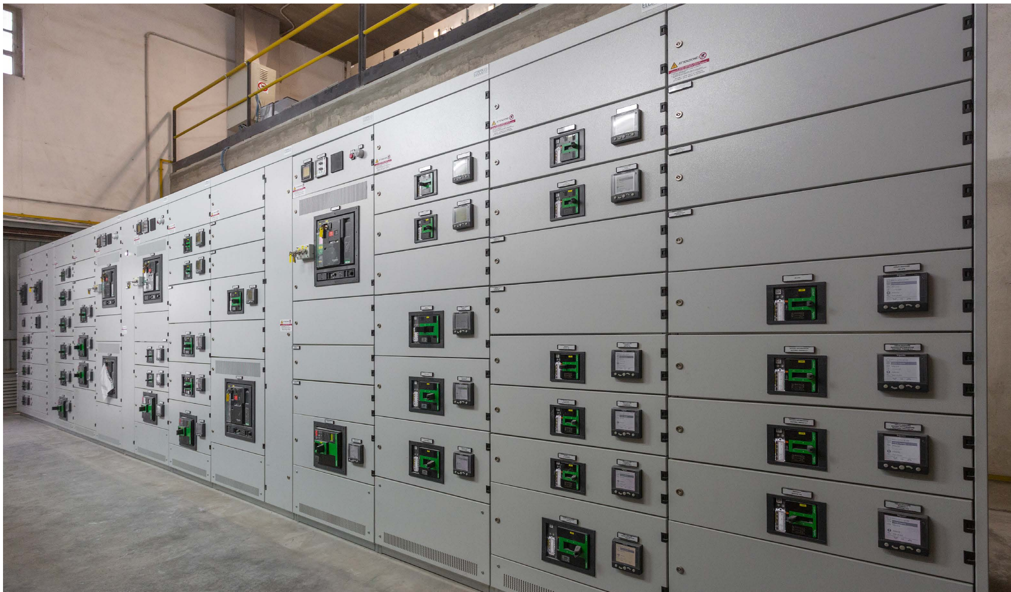
↑ Vista completa del quadro Power Center installato, con unità di protezione, misura e comando.
