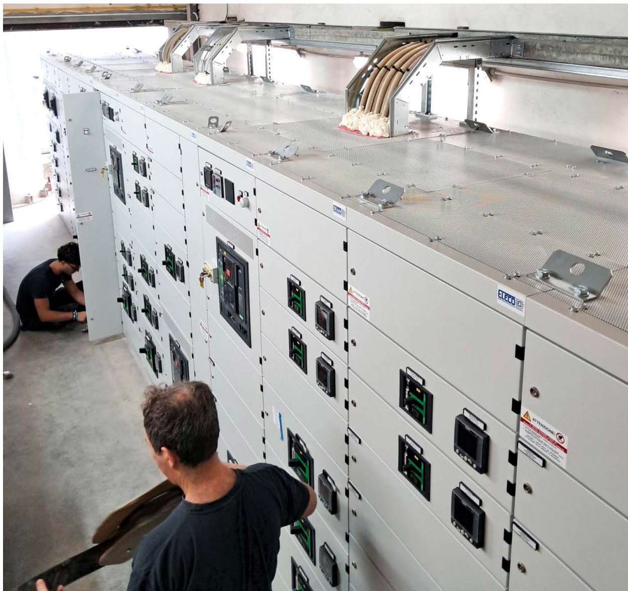
↑ Vista superiore nuovo Power Center con uscita cavi verso passerelle esistenti.
