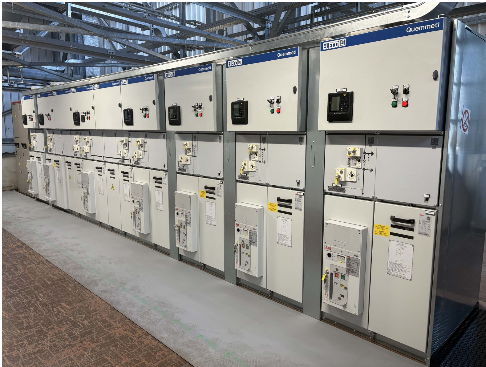
↑ Vista della sezione di Media Tensione della cabina.
