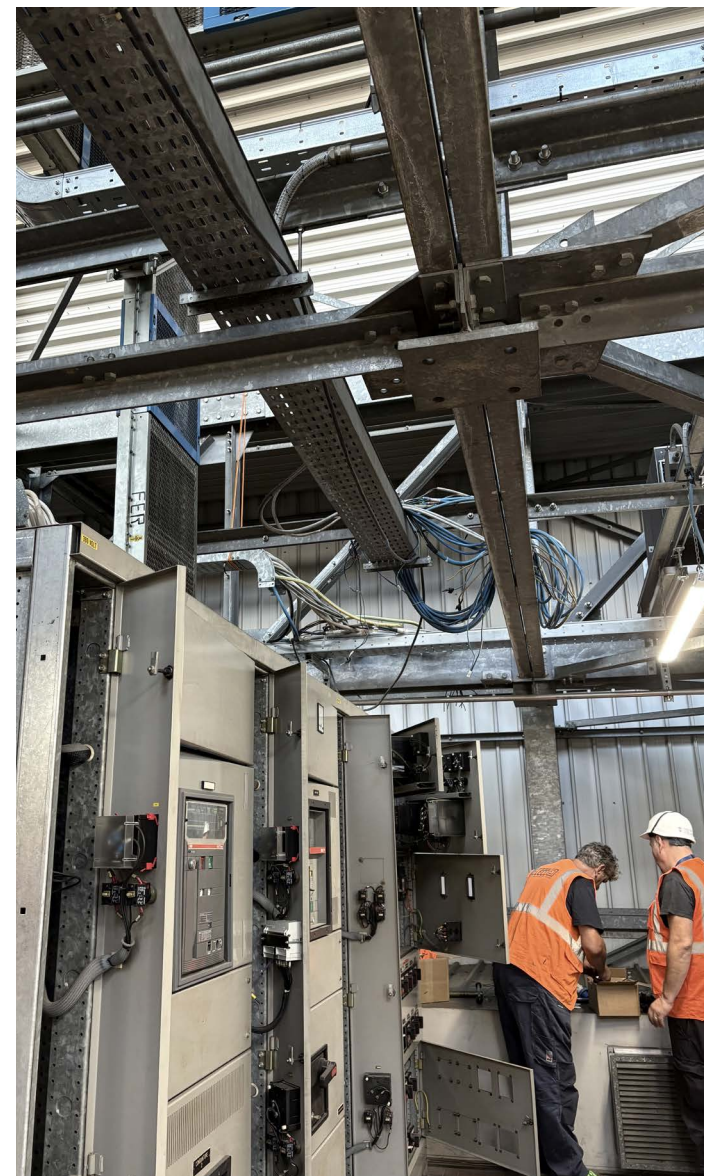
↑ Fase di smontaggio quadri esistenti.
