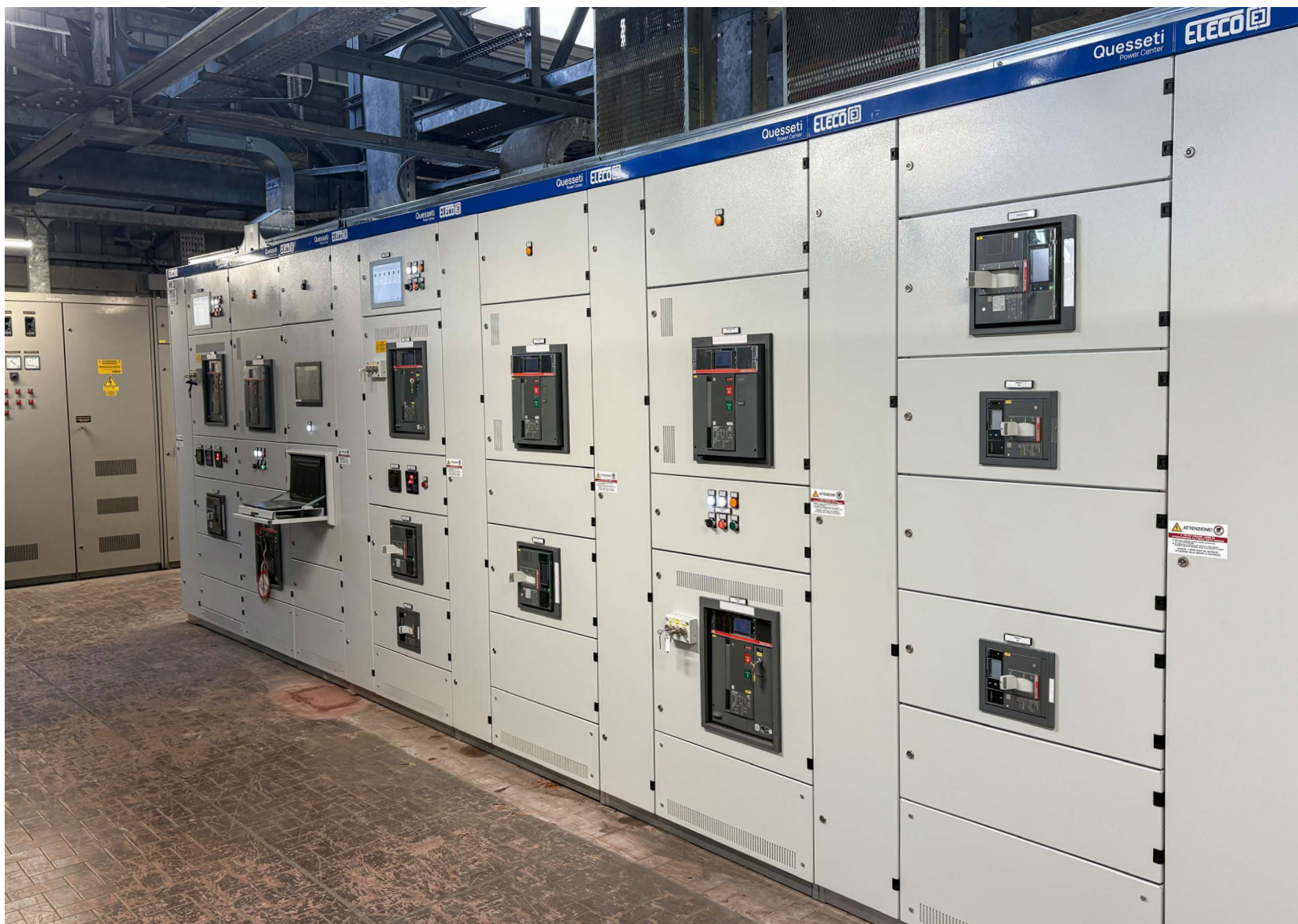
↑ Vista di insieme del nuovo Power Center installato in cabina.
