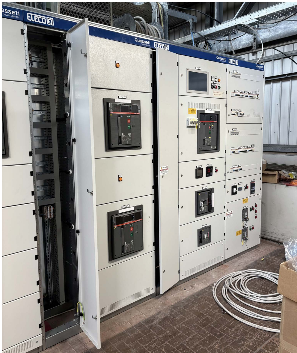
↑ Fase di installazione del quadro in cabina, con predisposizione dei collegamenti di potenza e ausiliari.
