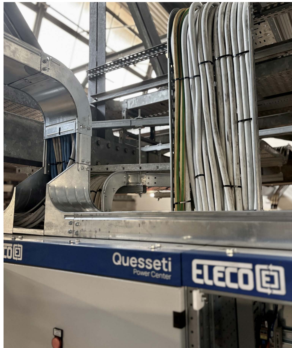
↑ Dettaglio dei nuovi collegamenti e canalizzazioni.
