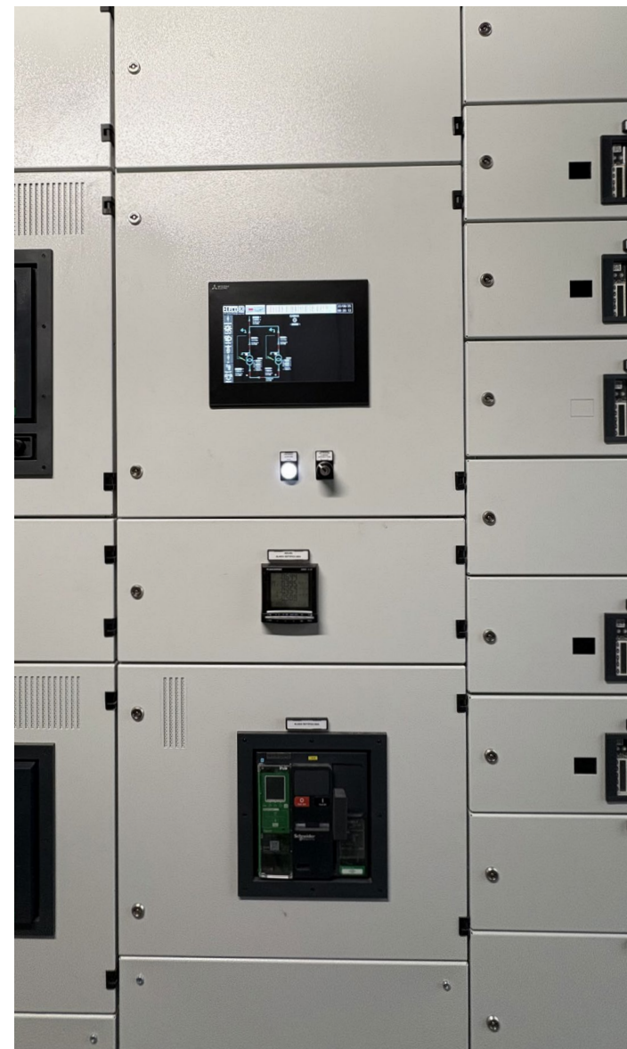
↑ Dettaglio interfaccia SCADA integrato sul Power Center.
