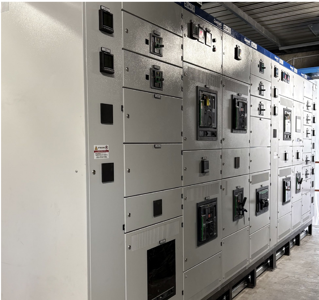
↑ Vista laterale del Power Center con distribuzione modulare.
