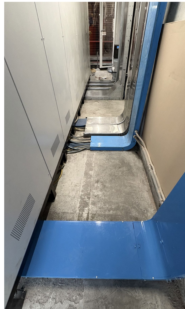
↑ Canalizzazioni di potenza e ausiliarie.
