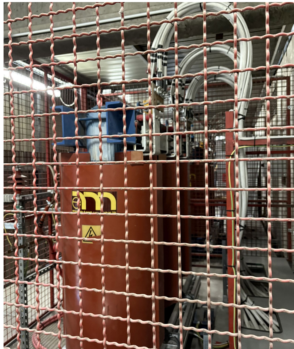
↑ Trasformatore MT/BT mantenuto e integrato nel nuovo assetto.
