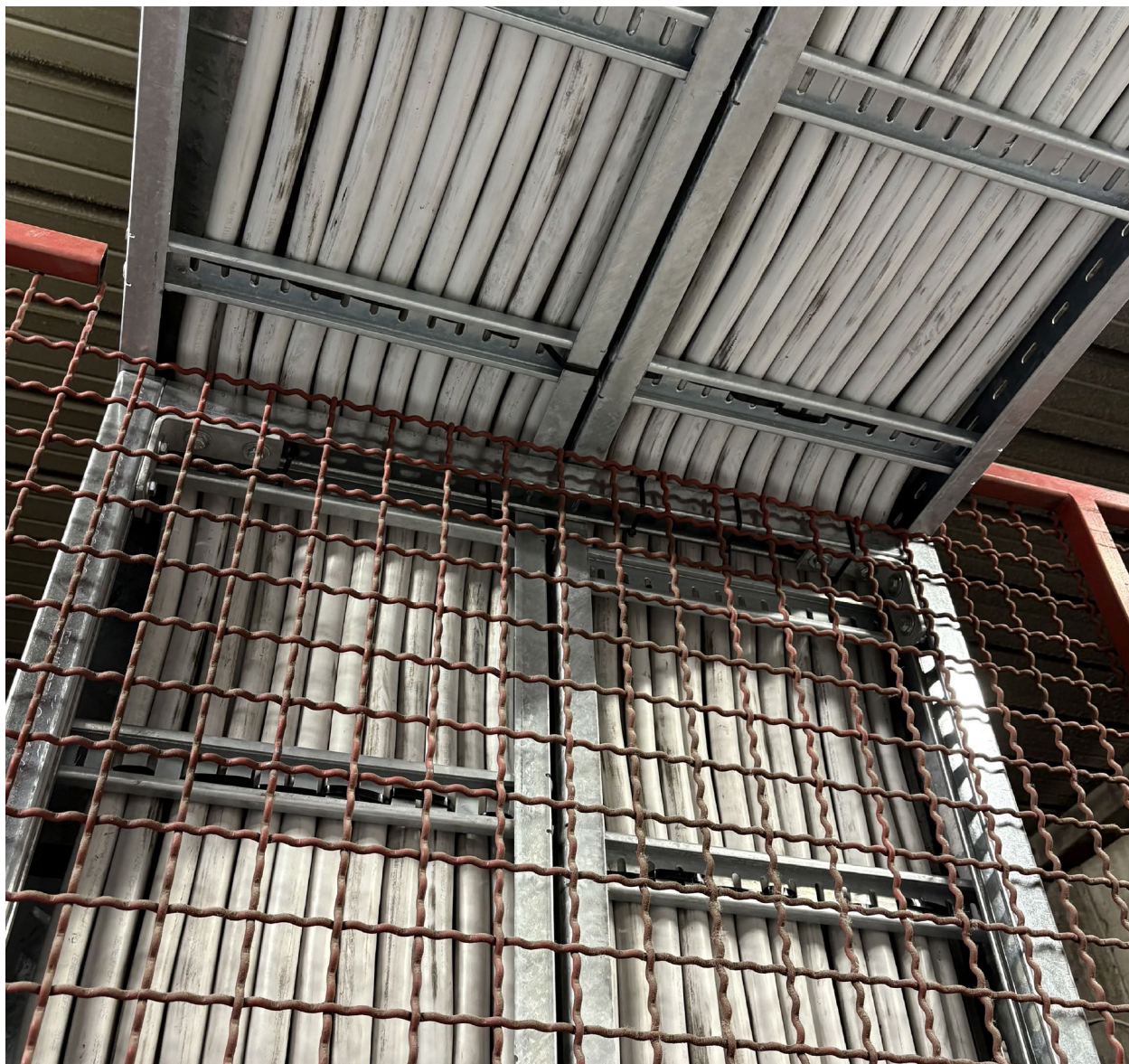
↑ Instradamento delle linee elettriche su passerelle metalliche, a supporto della continuità e dell'ordine.
