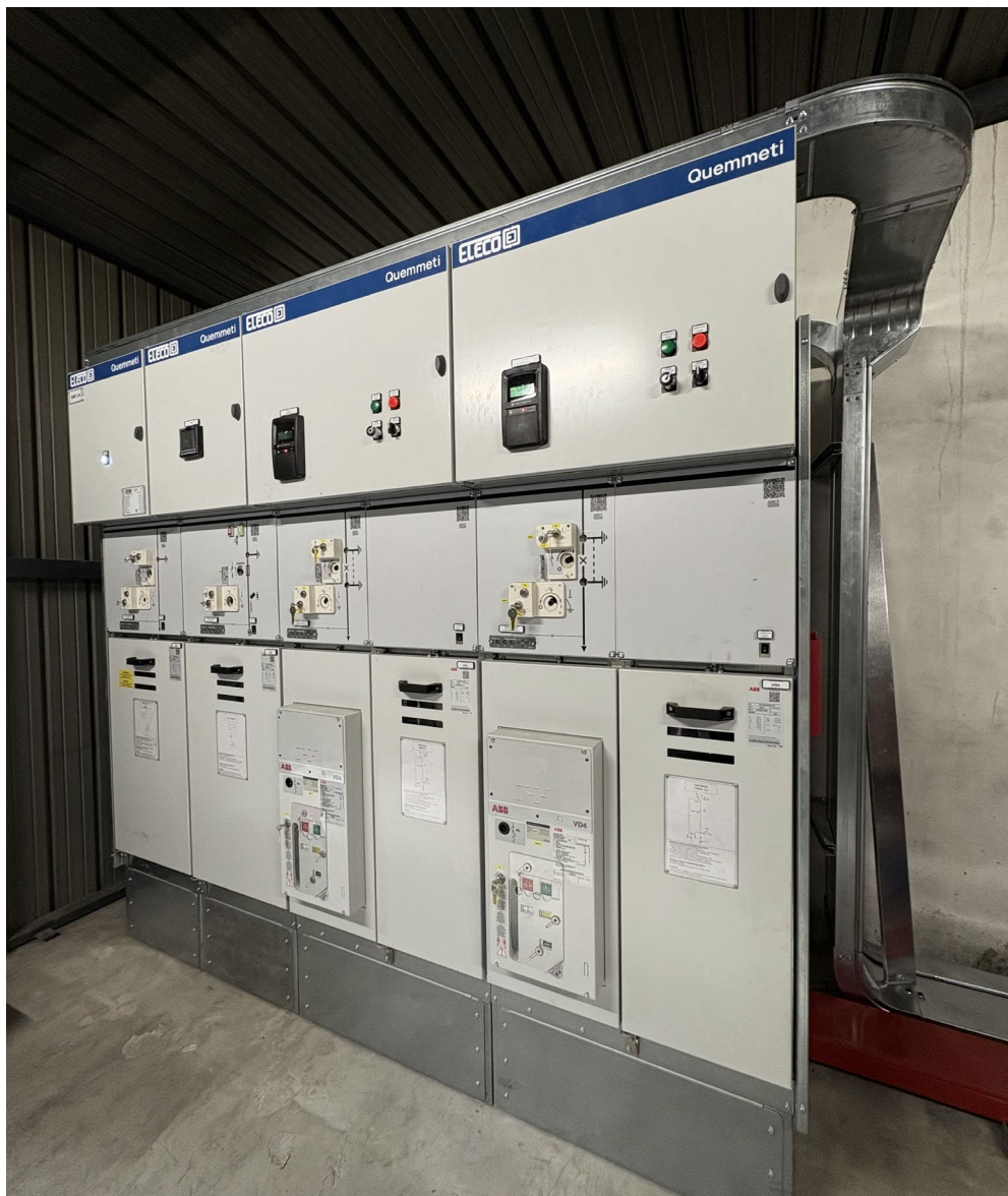
↑ Quadri di Media Tensione installati in cabina..
