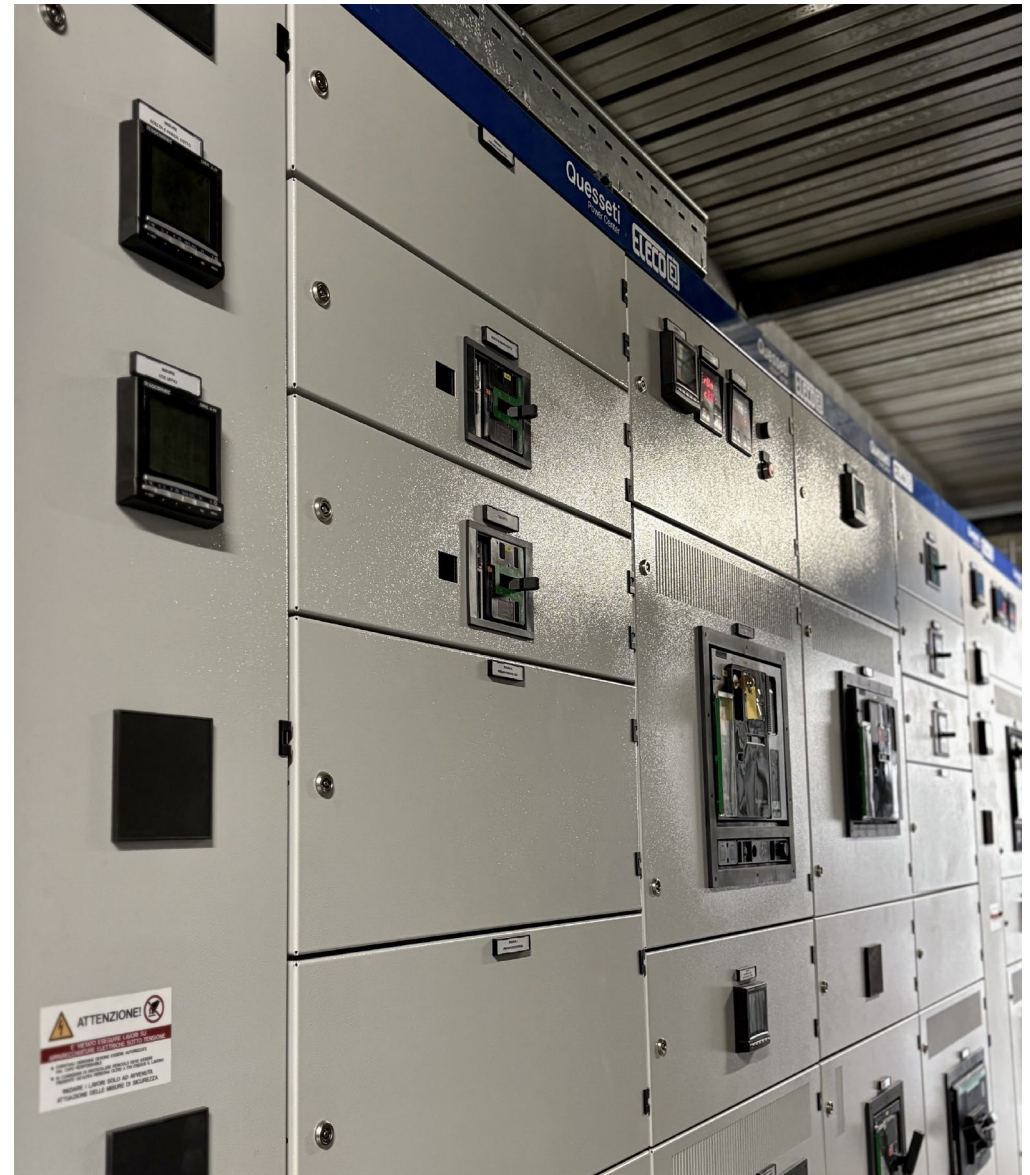
↑ Dettaglio del Power Center QGBT installato in cabina.
